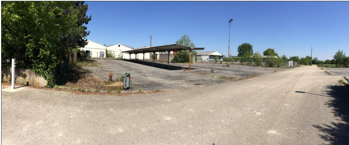
Vue du site depuis la rue de l'Irance (au sud)
