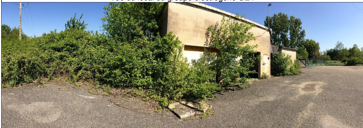
Vue du local du groupe électrogène GE4
