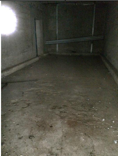
Vue d'une ancienne chambre froide – secteur porcherie/découpe
